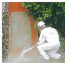
300~500bar/30l/min 水喷沙无粉尘除漆除锈
