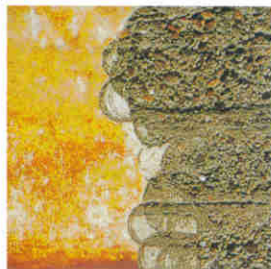
500~1500bar 树脂涂层地面和混凝土表层剥离
