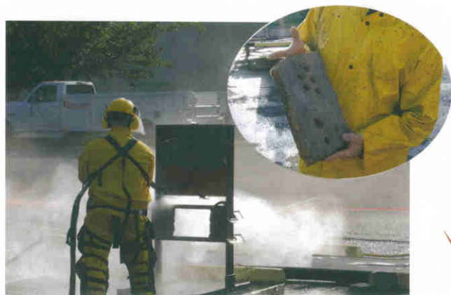
清除漆锈，破碎混凝土或石板
