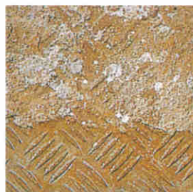
500bar/30l/min 清理建筑模板上的水泥
