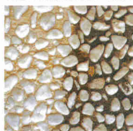
350~500bar 混凝土“拉毛”
