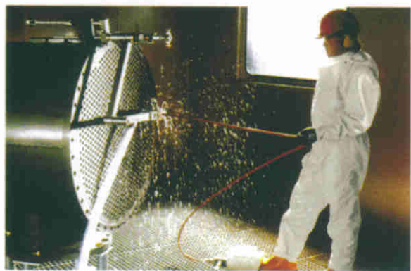
清洗各类工业，换热器，管道，反应釜等
